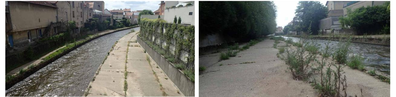
Figure 87 Perré bétonné en partie aval du Sichon dans la traversée urbaine de Vichy – Biotec, Juin 2016.
