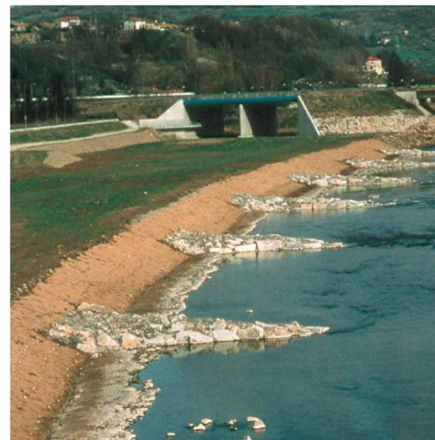
Figure 15 Illustration d'épis réalisés sur la Loire à Brive Charrenssac (43).
