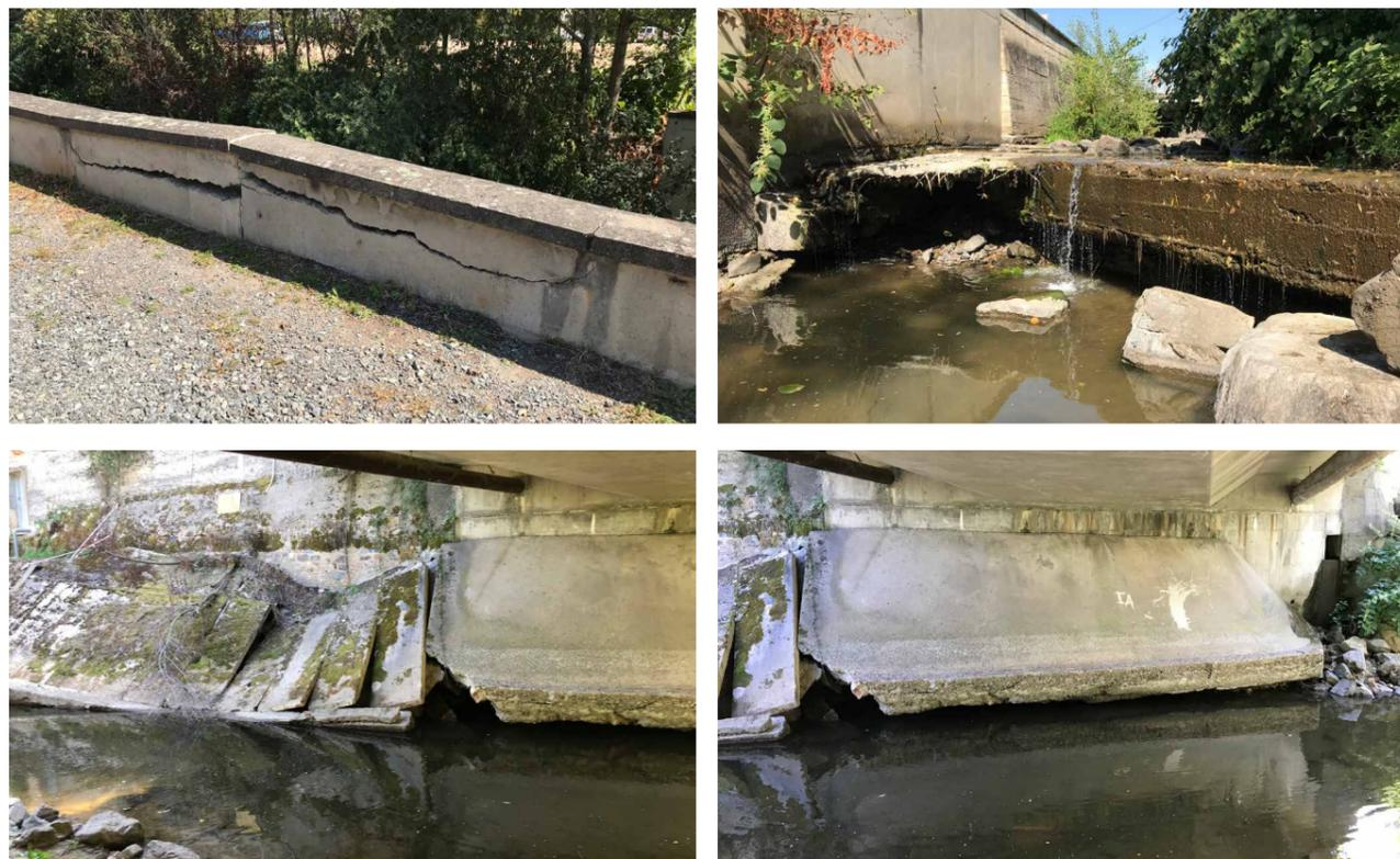
**Figure 71** Illustrations en haut du seuil très affouillé sur le Jolan, du mur présent sur sa droite au droit de la rue de la Combe Bessay, puis en bas des parpaings béton en rive gauche du Sichon au point de confluence Sichon-Jolan (photos Biotec 12.09.2018).
