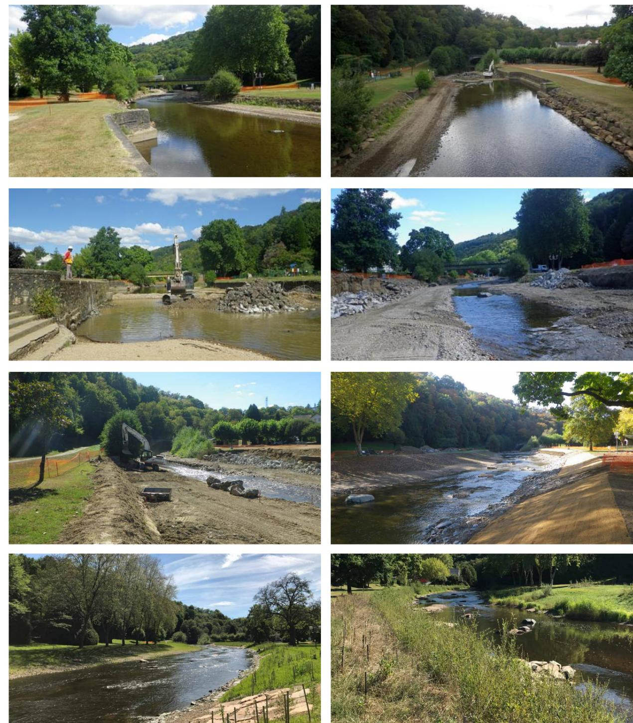
Figure 21 Images références illustrant les ambitions d'aménagement du Sichon de Presles : démolition puis de renaturation des berges de la Corrèze à Tulle au droit du parc de l'Auzelou (travaux automne 2016, début de reprise végétale au printemps 2017, puis état de l'aménagement à l'été 2018). Conception, photos et maîtrise d'œuvre : Biotec.
