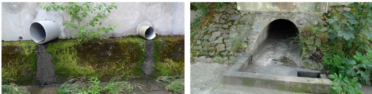
Figure 99 Exemple de rejets d'eaux pluviales à rétablir (Source : Biotec 2018).
