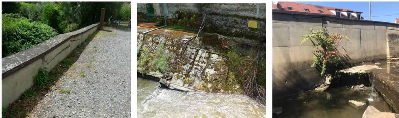
**Figure 22** Illustrations des nombreuses altérations du génie civil du seuil du Jolan et des soutènements des ponts, voiries et réseaux à proximité de la confluence Jolan/Sichon (Source BIOTEC 2018).
