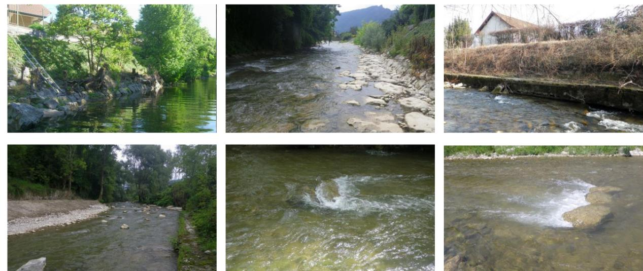
**Figure 12** Illustrations successives de « banquettes »/protections de pied de berge et murs en enrochements et aménagements piscicoles sur le Sierroz à Aix-les-Bains, pour rehaussement de la lame d'eau à l'étiage, diversification des écoulements et protection des perrés (2014; conception, photos et maîtrise d'œuvre : Biotec).
