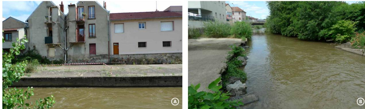
**Figure 1** Illustrations de certaines des altérations du Génie civil des berges, observables sur le tronçon de Sichon étudié : A) Affaissement de la rive droite au droit d'une canalisation d'eaux usées, B) Affouillement puis effondrement d'une partie de la risberme béton (Source : Biotec 2018)
