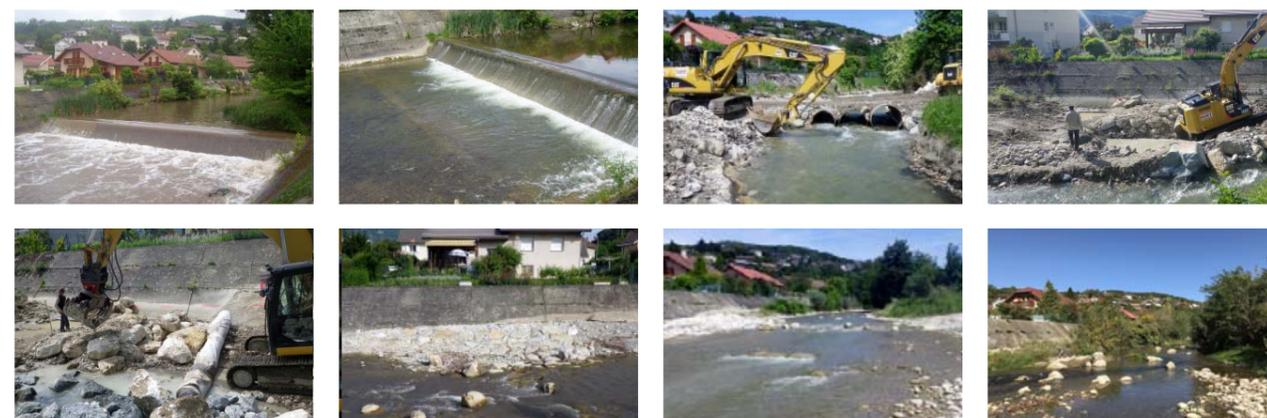
**Figure 13** Illustrations successives de la démolition du seuil amont du pont Rouge sur le Sierroz à Aix-les-Bains puis constitution d'une rampe franchissable en enrochements de faible hauteur de chute (dénivelé 40 cm) (2014; conception, photos et maîtrise d'œuvre : Biotec).
