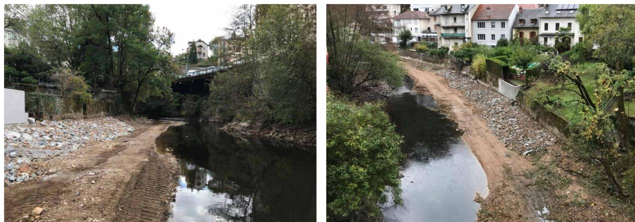
**Figure 11** Illustrations de pistes de chantier en lit mineur quasi à fleur d'eau en étiage sur la Corrèze en ville de Tulle, où les accès chantier sont également très contraints (photos et maîtrise d'œuvre Biotec ; chantier automne 2018).
