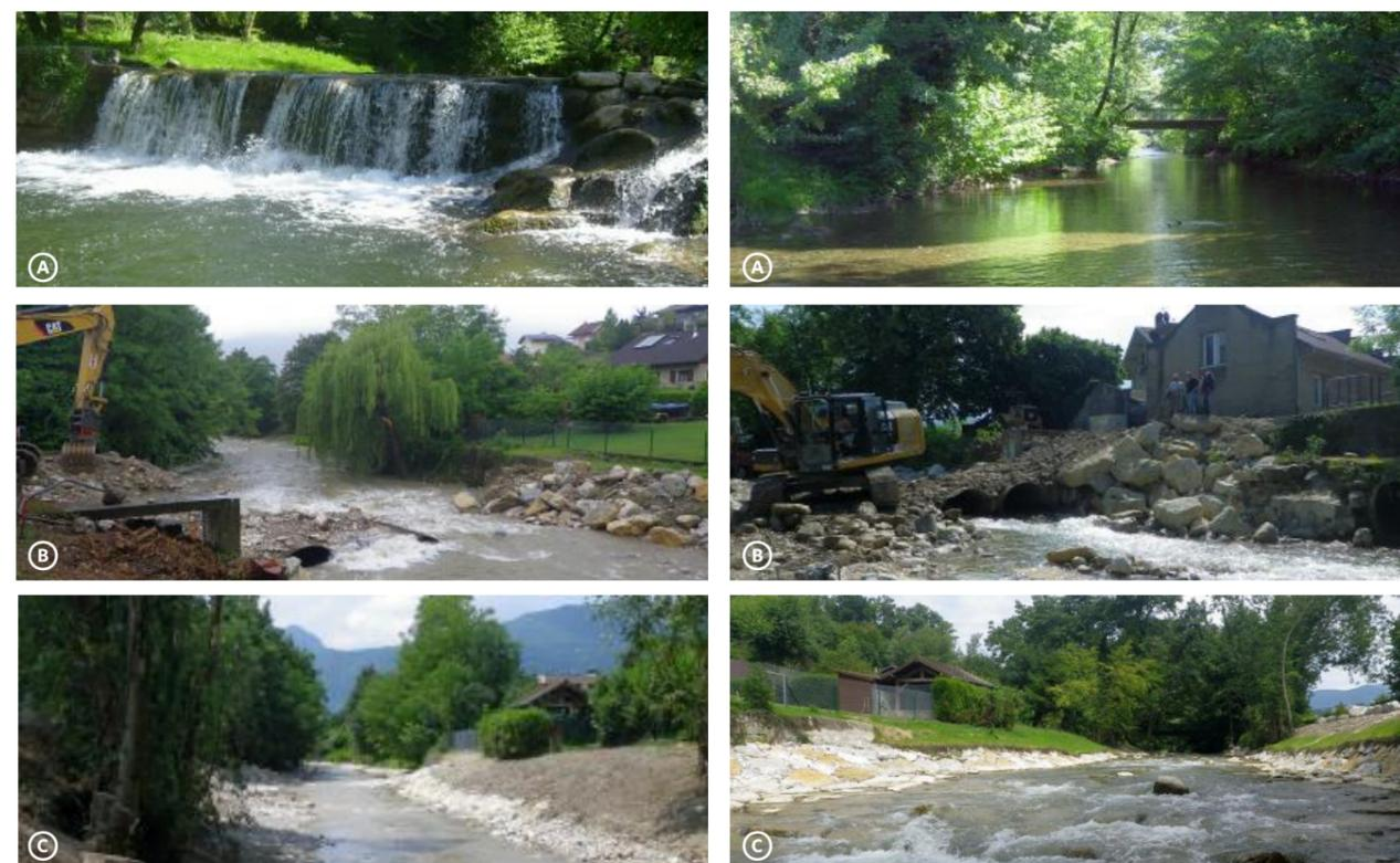
**Figure 32** Images références illustrant les aménagements du seuil du Jolan, : seuil de Lafin sur le Sierroz à Aix-les-Bains en trois rampes en blocs successives (pente 4% chacune, 0.4 mètre de hauteur de chute par rampe) (conception, maîtrise d'œuvre et photos : Biotec), avec : A) état initial du seuil et de sa «retenue» (mai 2011), B) travaux de démolition en cours (mai-juin 2014), C) état finalisé du lit sous la forme de trois rampes successives en blocs (juin et août 2014).
