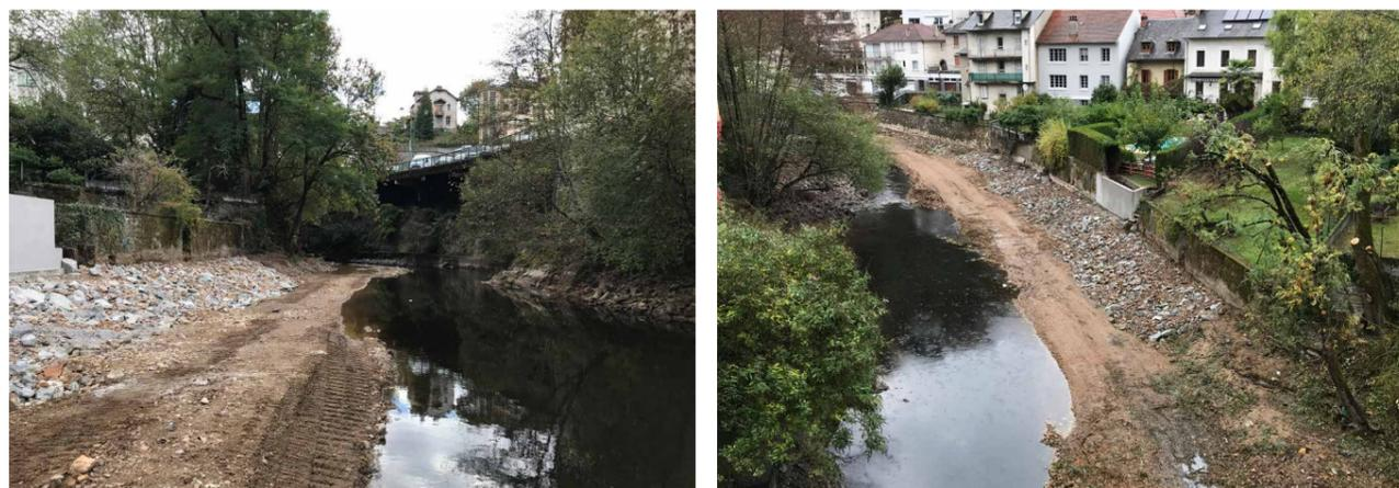
**Figure 30** Illustrations de pistes de chantier en lit mineur quasi à fleur d'eau en étiage sur la Corrèze en ville de Tulle, où les accès chantier sont également très contraints (photos et maîtrise d'œuvre Biotec ; chantier automne 2018).
