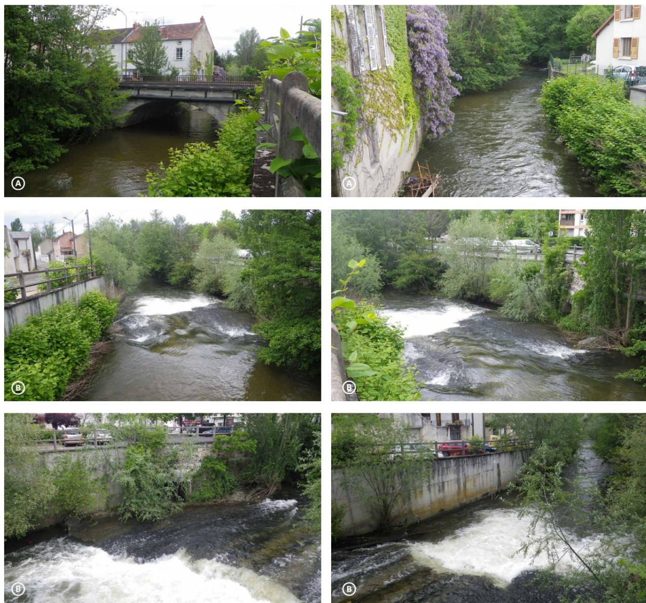
**Figure 69** Différentes vues du seuil aval de l'avenue de Vichy (photos Biotec 18.05.2016), avec : A) pont de l'avenue de Vichy, en amont immédiat du seuil et effet «retenue» du seuil à l'amont; B) le seuil et affouillement visible de la structure bétonnée sur sa partie aval.
