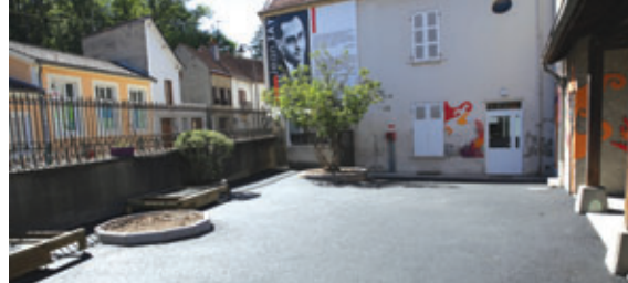
Réfection des salles de classe. Ecole Darcins Elémentaire
